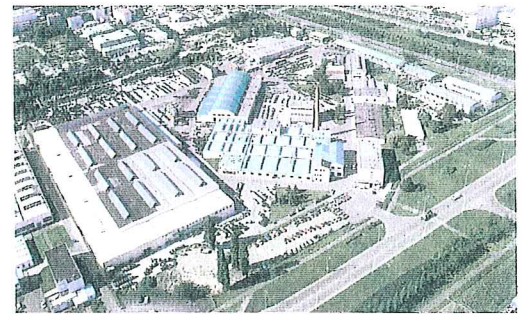
Die Prakab Prazska Kabelnovna, a.s. (PRAKAB) mit Sitz in Prag ist das Produktionszentrum für die gesamte Gruppe sowie das Logistik- und Kundenzentrum für den tschechischen Markt
